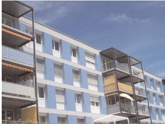
Rénovation : ici à Pesoux, selon le standard Minergie.
